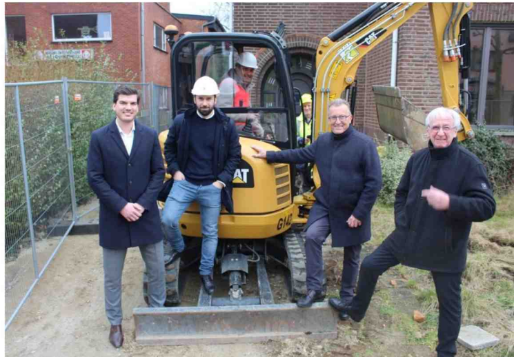
De burgemeester mocht vrijdag de eerste sloopwerkzaamheden uitvoeren. ©TORO
