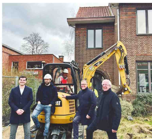
Deze week wordt gestart met de sloopwerken van de vroegere kapelanjien in Zonhoven. Foto GLH
