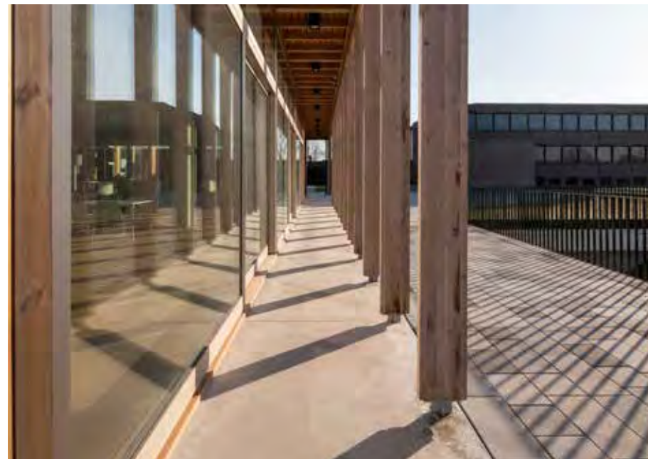
IOK kantoorgebouw - Geel
